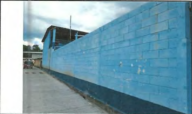
Foto 3: Muro con falta de reforzamiento en la cimentación lo cual hace que se mueva al momento de fuertes vientos y sismos.
