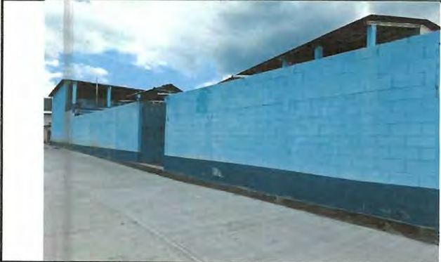
Foto 1: Muro perimetral lado norte de la escuela (área a intervenir)
